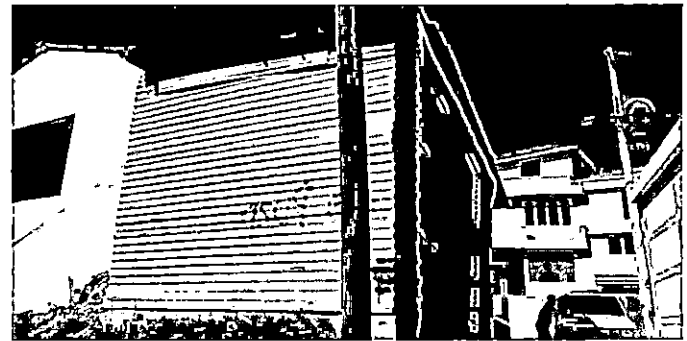
Foto 2: Sustitución de lamina por block en pared.
